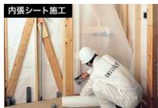
内張シート施工
